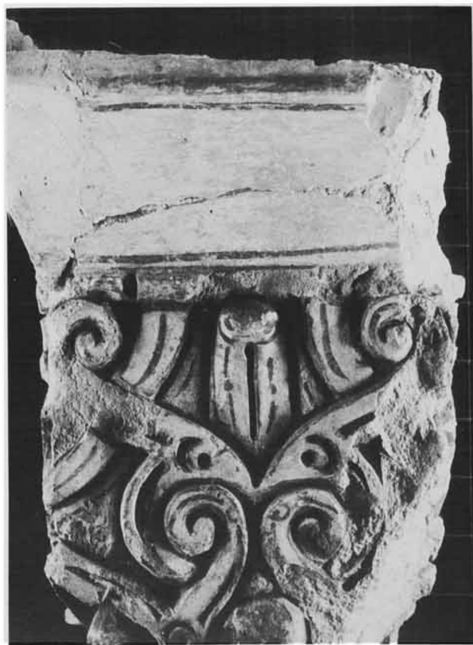
Estado original del capitel, donde se aprecia una deficiente intervención. — Las piezas se han pegado y reintegrado con mortero de yeso basto y estopa. — El poco cuidado en la colocación de los fragmentos ha provocado escalonamientos y desajustes que desvirtúan la imagen del capitel.
