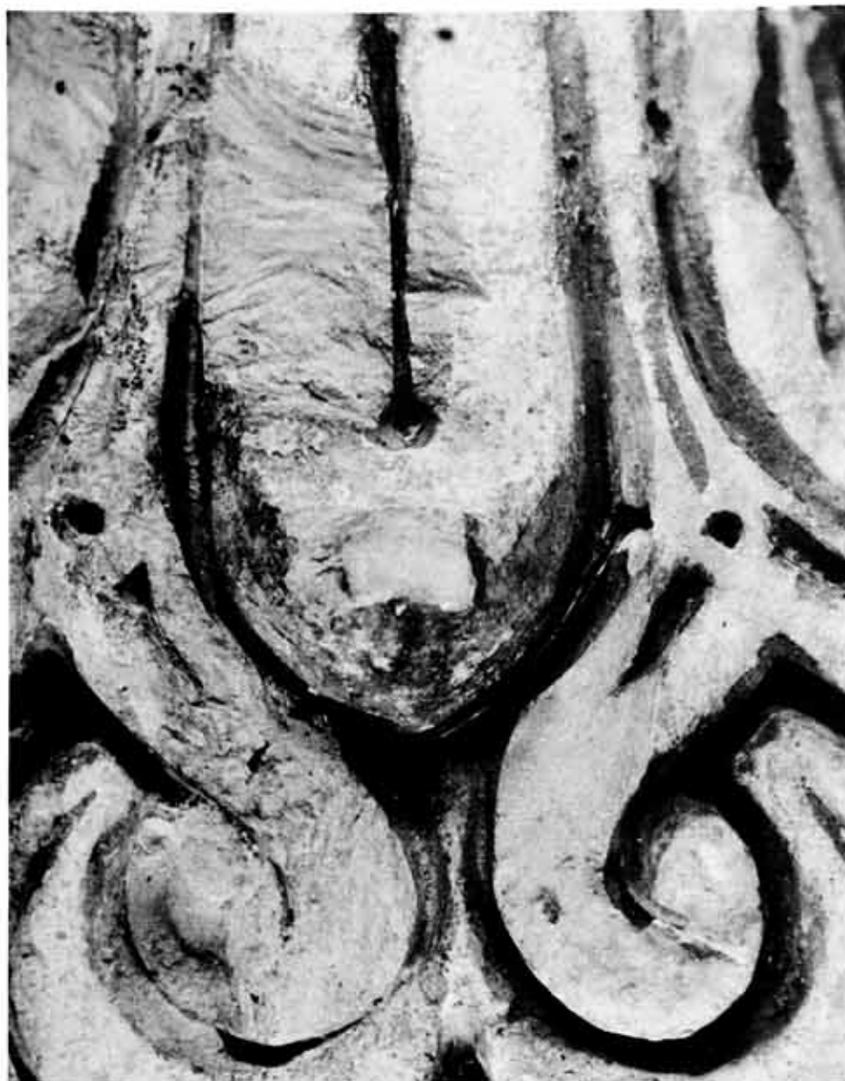
Detalle del capitel, donde vemos la utilización de elementos para la fijación a la pared, efectuando taladros, e incluyendo materiales, en este caso alambres, que han oxidado y contaminado la pieza.
