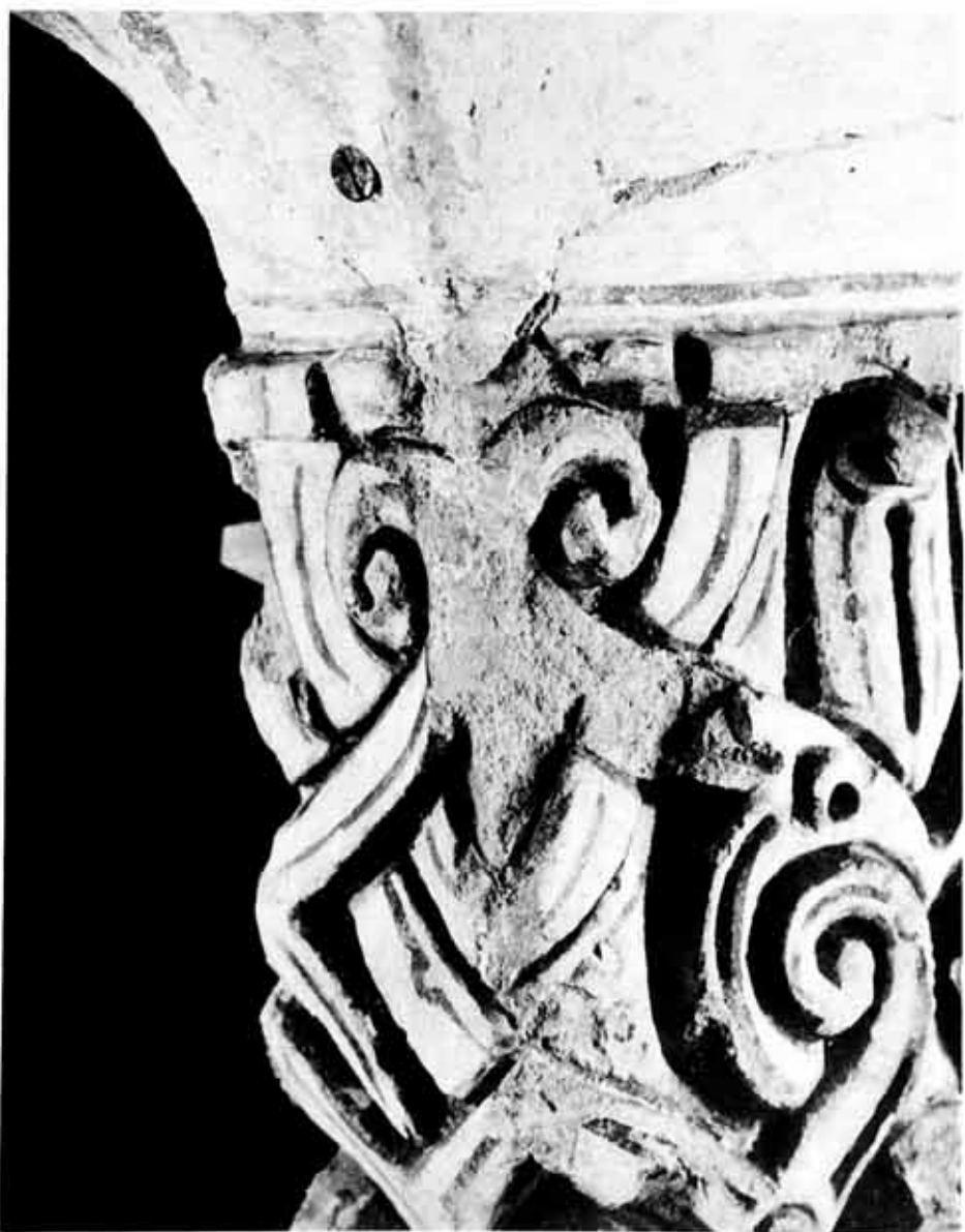
En la unión de los diferentes trozos se utilizó, en anteriores intervenciones, morteros de yeso y escayola, lo que provocó una deficiente instalación y casado, apreciándose claramente escalonamientos y volúmenes que no correspondían a la verdadera imagen original. También se observaron elementos de unión como clavos, tornillos, etc., que hipotéticamente se pensó servirían para la sustentación y cohesión del bloque.
