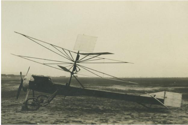
**PRIMER AUTOGIRO, EL MODELO C-1, UTILIZANDO EL FUSELAJE, RUEDAS Y ESTABILIZADOR VERTICAL DE UN MONOPLANO DEPERDUSSIN Y UN MOTOR LE RHÔNE DE 60 CV, SOBRE EL QUE MONTÓ DOS ROTORES CUATRIPALAS CONTRAROTATORIOS CORONADOS POR UNA SUPERFICIE VERTICAL DESTINADA A PROPORCIONAR CONTROL LATERAL.**
